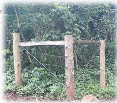
Figura 4: Exemplo da cerca construída com canto duplo em ângulo
