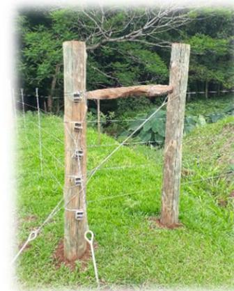
Figura 1: Exemplo da cerca construída com canto duplo
